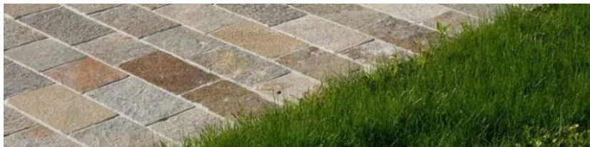
Alternative 1 Luserna Gneis – Plattenbelag in gebundener Bauweise gesägte Kanten, bruchrau gespalt
