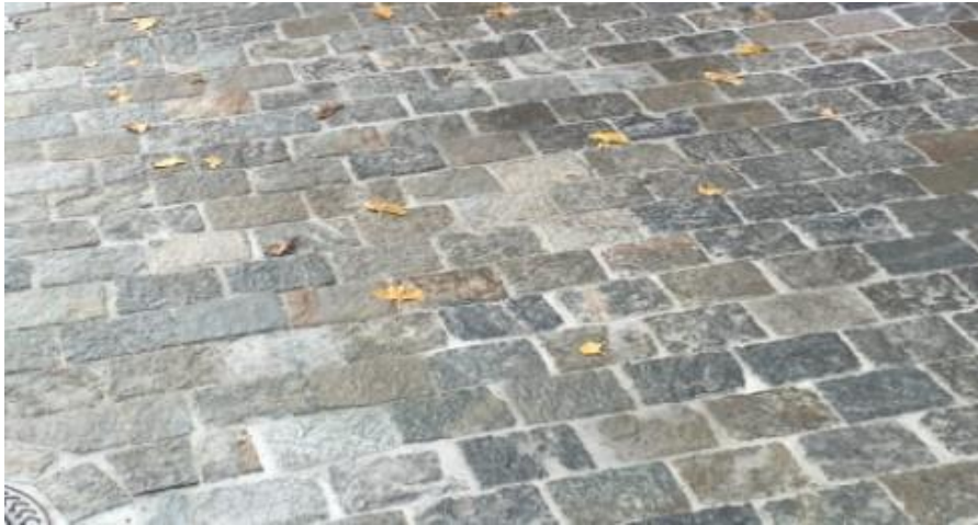
Luserna Gneis – Bindersteine in gebundener Bauweise
